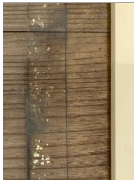
左から表に出ている部分、板に隠れていた部分、仮設の外枠
